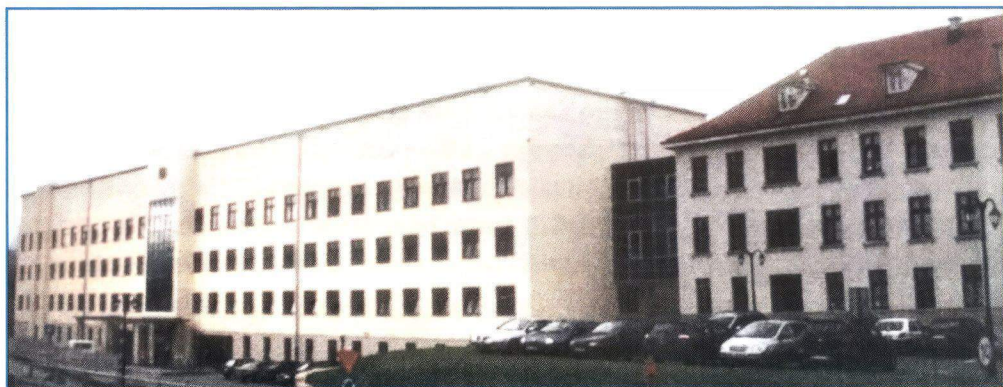
Главное здание «Ставки Западного направления» (слева) связано со зданием Главного штаба Северной группы войск (справа). Строительством руководил главный инженер 855-го УНР майор Стратий В. А.
