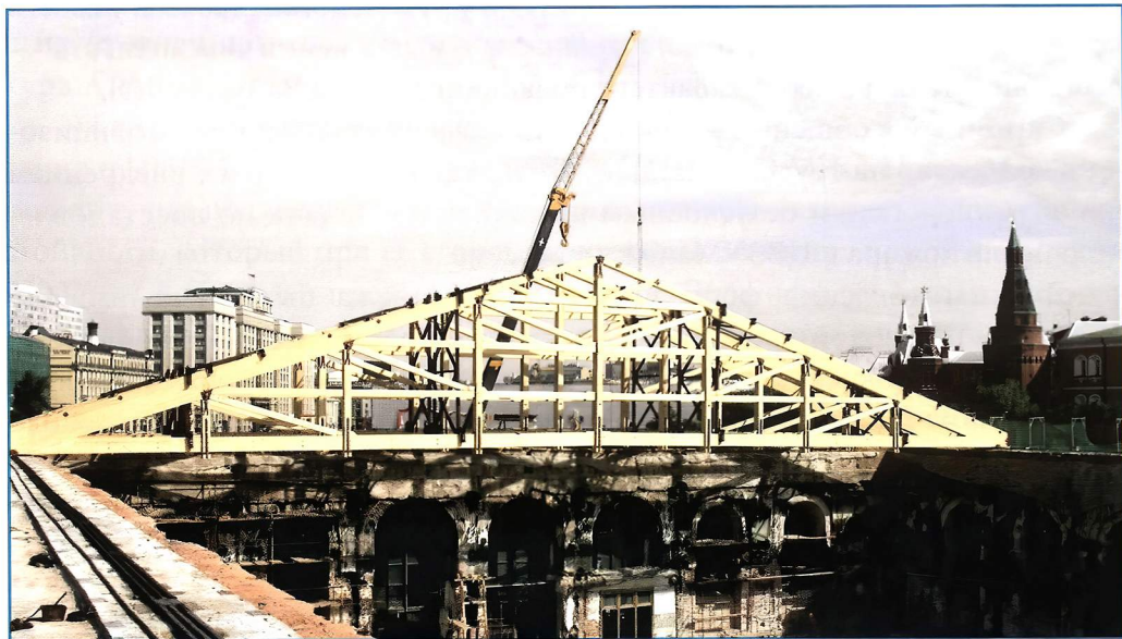
Начало монтажа уникальных деревянных ферм перекрытий Бетанкура А. А.
