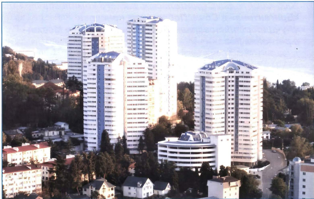
Жилой комплекс «Бригантина», г. Сочи, построенный инвестором ОАО «ХК ГВСУ «Центр» в 2007 году
