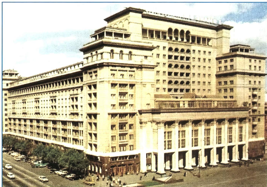
Гостиница «Москва» после завершения реконструкции в 1978 году
