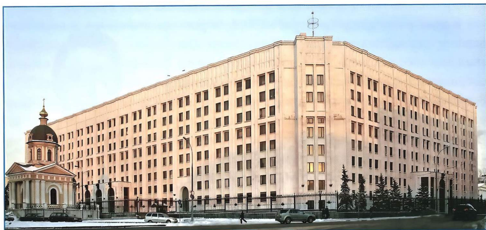
Строительство уникального комплекса Генерального штаба Вооруженных сил осуществляло ГВСУ «Центр»
