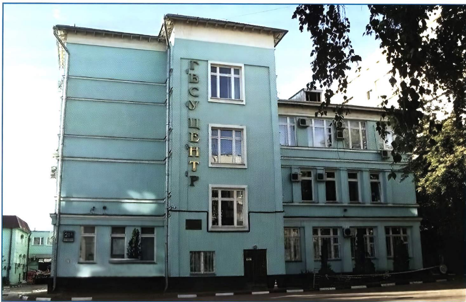
Здание ГВСУ «Центр» по адресу Москва, улица Воронцовская, дом 21
